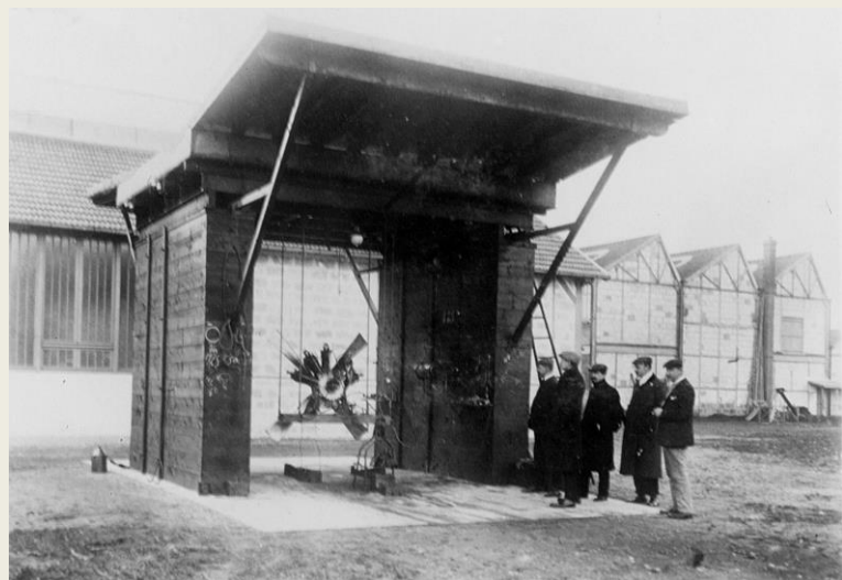
Banc d'essais moteur à l'usine REP. (Archives municipales de Boulogne-Billancourt).
