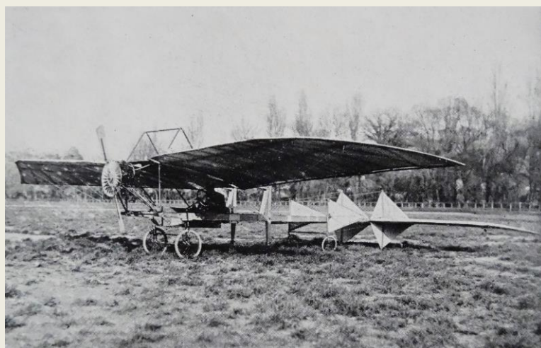
Dès le printemps 1908, tel Henri Blanc, beaucoup de pionniers de l'aéroplane ont choisi le moteur REP 35 ch en éventail. (La France Automobile et Aérienne).
