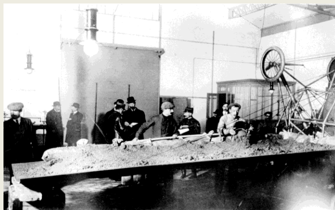
En décembre 1912, sur les appareils militaires, ont lieu à l'usine de Billancourt les premiers essais de résistance des matériaux réalisés dans le monde. Des sacs de sable sont chargés sur les ailes jusqu'à leur rupture. (Cliché Archives municipales de Boulogne-Billancourt).
