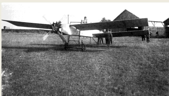
Avant Blériot, l'aérostier-ingénieur Henri Kapférer en 1908 utilise un moteur et une hélice R.E.P. sur son monoplane. (Musée de l'Air).
