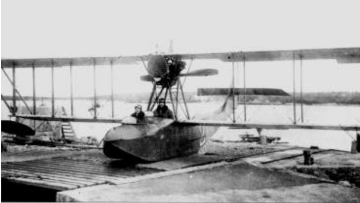
*Hydravion Donnet-Denhaut type DD-8 à moteur Lorraine V8 de 170 ch. Deux cents de ces hydravions de combat furent commandés par la Marine en 1916.*
