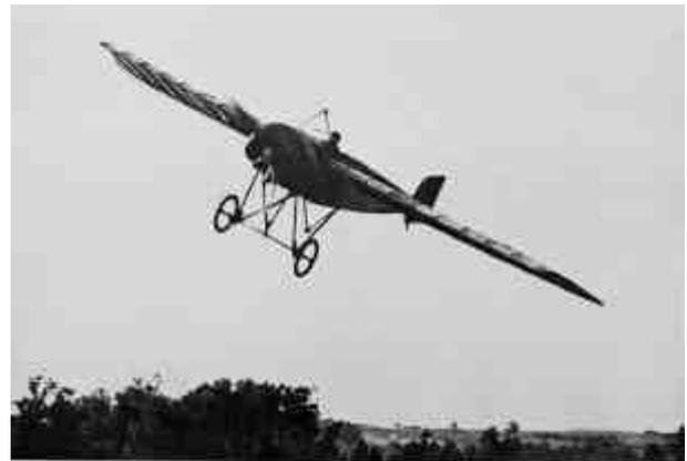
**Audemars, le 16 juillet 1913. virant à sept mètres du sol avec son monoplan Morane-Saulnier à moteur Gnôme 80 ch. On voit nettement le gauchissement des ailes utilisé pour virer.**
