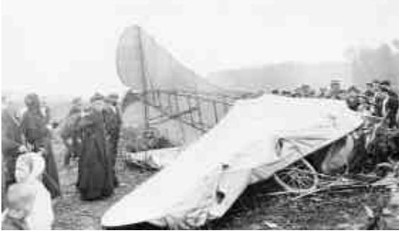
**Chute des frères Morane.** Léon Morane attribue sa chute à la rupture d'un câble de gauchissement de l'aile ; Blériot se défend en affirmant qu'un bidon d'essence mal arrimé dans le fuselage a bloqué les commandes.
