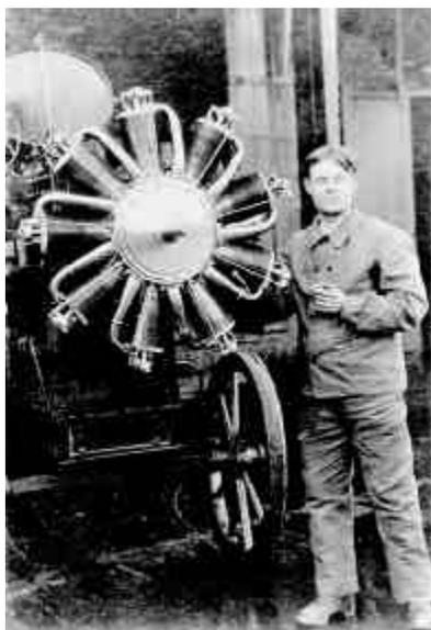
**Moteur Le Rhône de 80 ch au banc d'essais.** (Cliché collection Fournier).
