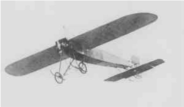
**Le Morane-Saulnier type "A", de Védrières, premier d'une longue série d'appareils : ailes aux extrémités arrondies, patins entre les roues, entoilage partiel (ici aux 6/7 du fuselage), 200 kg à sec, 280 kg à vide avec 100 litres d'essence et 35 litres d'huile, 430 kg avec pilote à bord et 115 km/h de vitesse maxi !**
