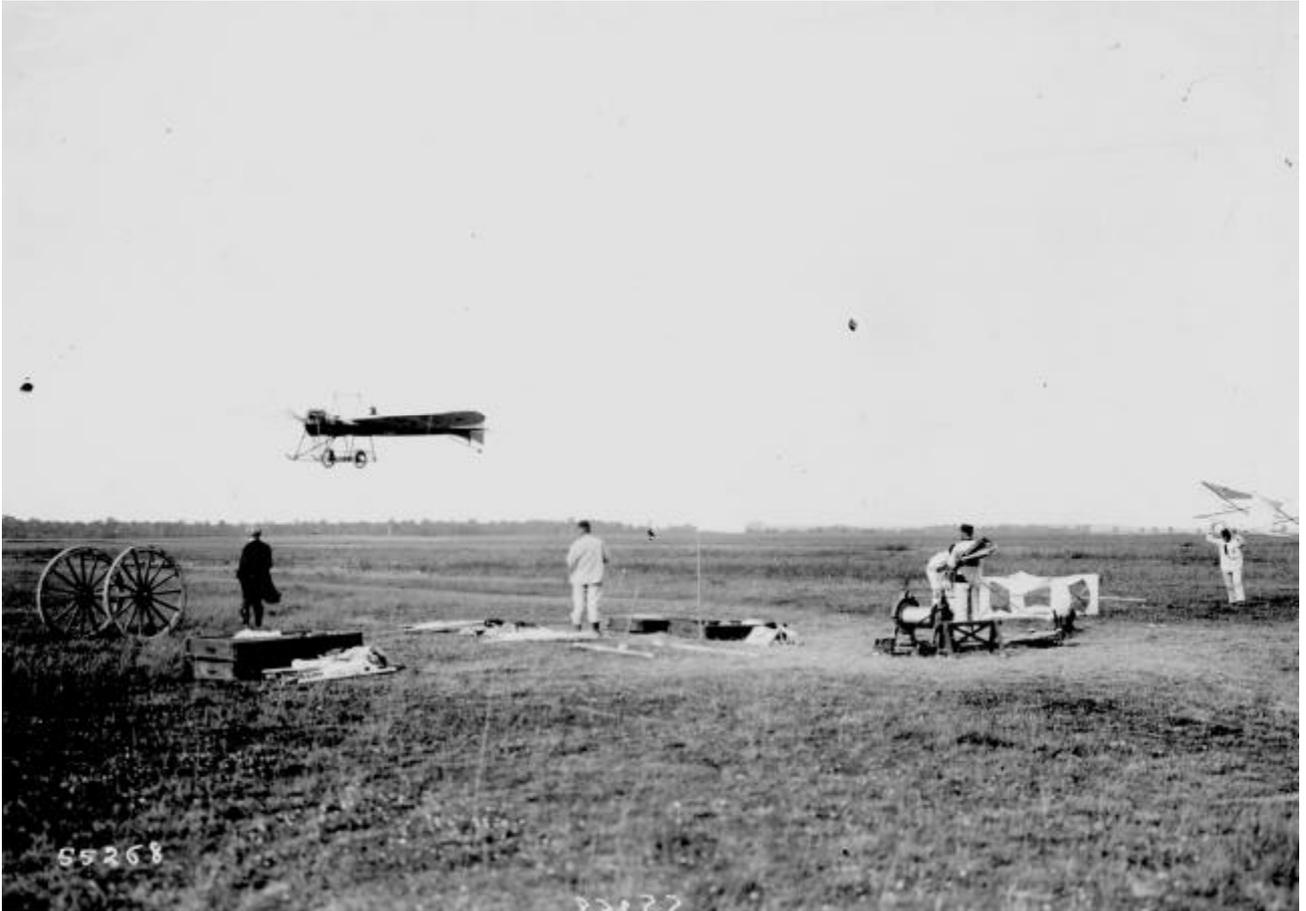
*Appareil Hanriot type IX à moteur Clerget 100 ch lors des essais de vitesse au concours de Reims 1911. (Collection M-H Clerget).*
