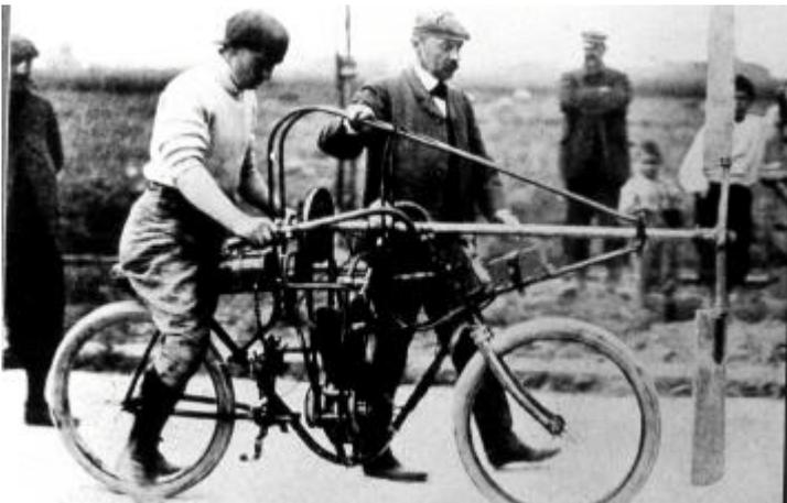
*Archdeacon et Anzani procèdent entre 1903 et 1905 à des essais de traction par une hélice sur une motocyclette.*
