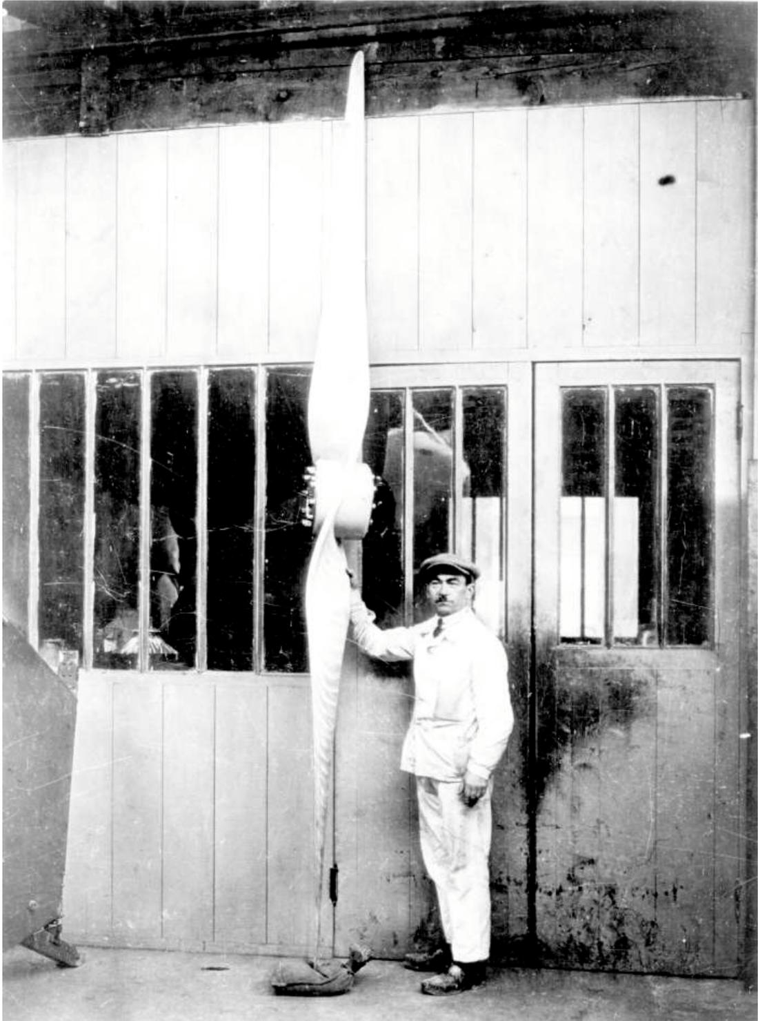
*L'une des premières hélices métalliques (en acier) construites à Issy-les-Moulineaux, en 1923 chez Nieuport-Delage : quatre mètres de diamètre, 200 kg.*
