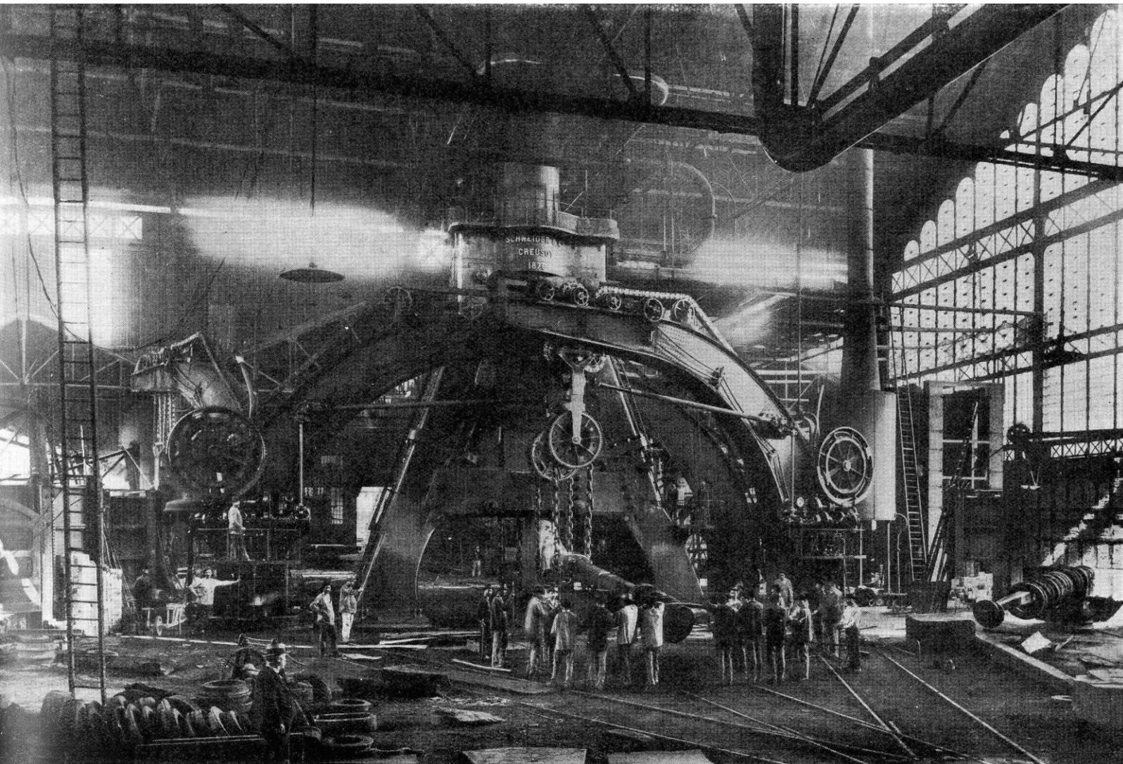
*Le marteau-pilon de 100 tonnes et la presse de 8 000 tonnes, usines Schneider du Creusot, juillet 1914.
