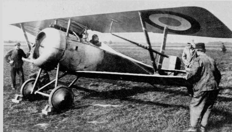
Nieuport 17 français. La mitrailleuse d'aile du Nieuport 11 a fait place à une mitrailleuse de capot, synchronisée. Cet appareil porte des lance fusées Le Prieur. (Musée de l'Air).
