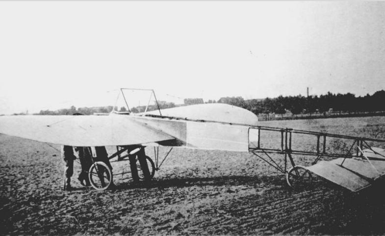
Le Blériot « militaire » est un monoplan renforcé de 8,45 m de long, deux places en tandem ou côte à côte, 18 m<sup>2</sup> de surface portante, 530 kg en charge, qui vole à 100 km/h avec le Lambda de 80 ch. (Cliché Blériot).
