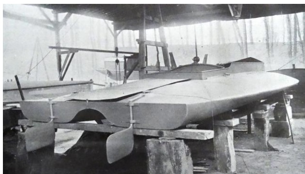
Le Racer Florio en construction aux chantiers de La Sirène à La Pallice près de La Rochelle, fin 1906. ( La France Automobile ).
