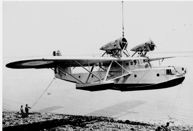
L'hydravion d'exploration trimoteur Loire 70 (1934) qui décolle à la masse de 11,5 tonnes est équipé de trois moteurs Gnome & Rhône de 750 ch. (Catalogue Loire-Nieuport 1936).
