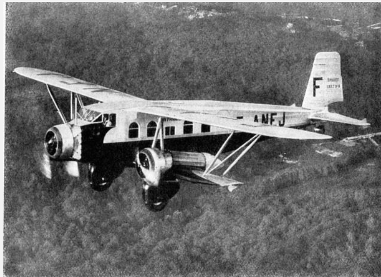
Trimoteur Breguet 393 à moteurs Titan Major de 350 ch utilisé par Air France sur la ligne d'Amérique du Sud (1934).
