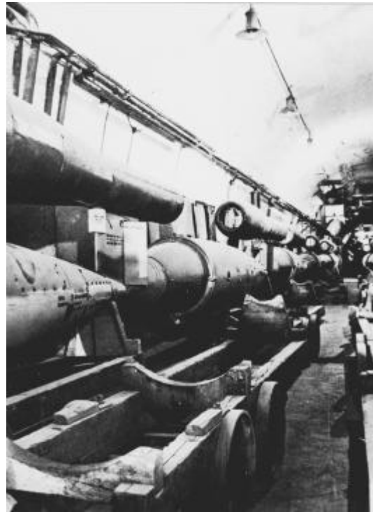
Site de construction souterrain des V-1 à Mittelwerk (1943).
