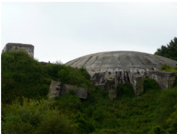
Le site de Wizernes, état en 2009. (Cliché de l'auteur).
