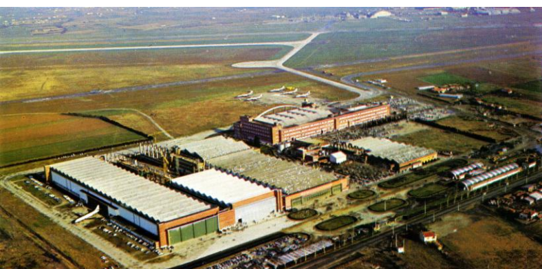
Usine de production des « Caravelle » et de « Concorde » de Saint-Martin-du-Touche (Toulouse), 1969. (USIAS).
