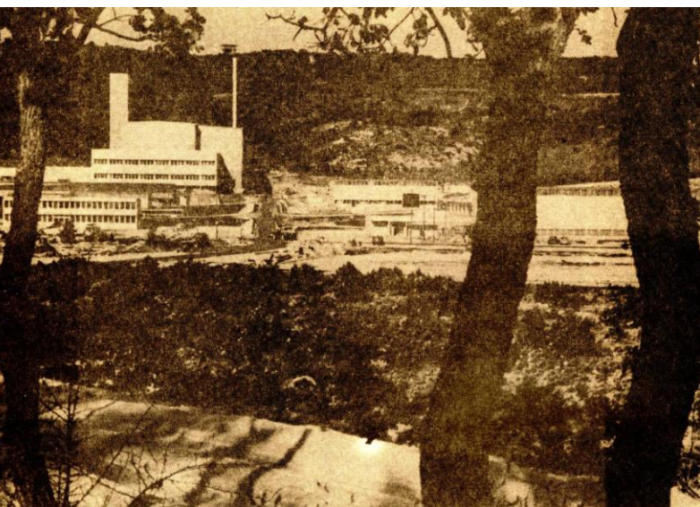
Cadarache (CEA), bâtiment abritant la pile nucléaire Pégase. (Photo Sud-Aviation 1967).
