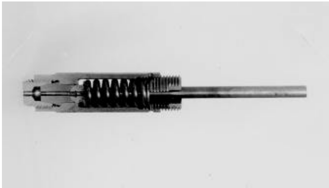
Rotules d'un tube d'injection Clerget, STAé. (Archives Clerget).
