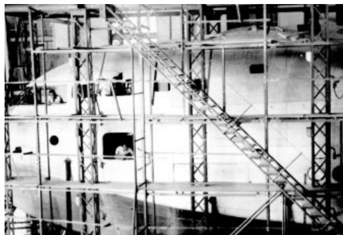
SE-200 n° 01 en construction à Marignane (1941). (Collection André Violleau).
