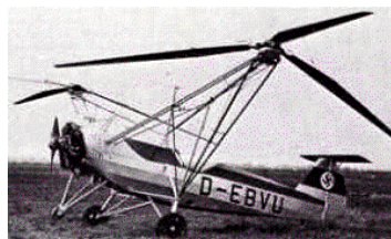
Focke-Wulf Fw-61 (1936), premier hélicoptère européen pilotable par des commandes, manche et palonnier. La machine est montée à 3 000 mètres et a volé à 110 km/h. (British Museum).
