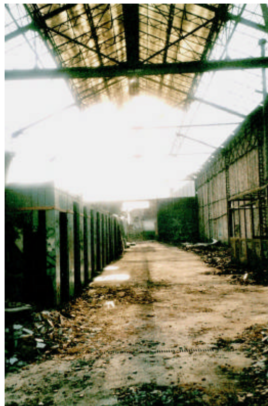
L'usine Ransome, été 2000, en cours de démolition.
