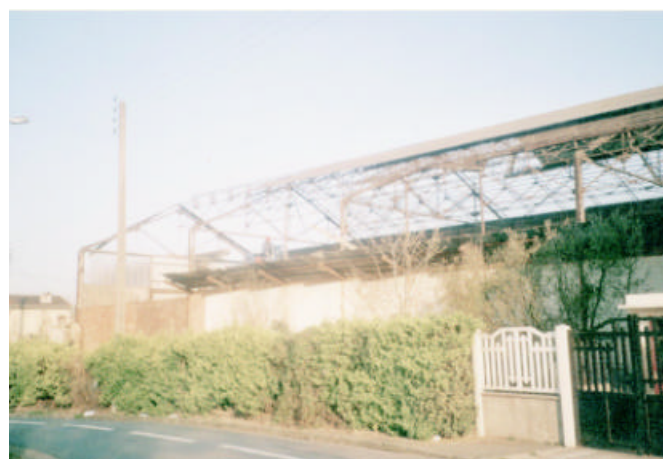
L'usine Ransome, été 2000, en cours de démolition.
