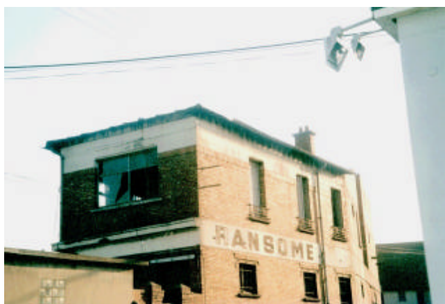
L'usine Ransome, rue Claude Monet à Argenteuil, avant démolition, été 1999.
