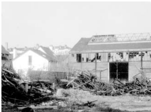
Bâtiments de la société Ransome où fut dessiné le SE-200 en cours de démolition en mars 2000. (Cliché Gérard Hartmann).
