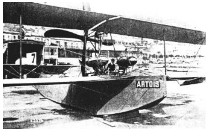
Hydravion d'Artois (Monaco 1913). Comme sur les autres projets, les réservoirs sont placés au-dessus du moteur. (Musée de Biscarrosse).
