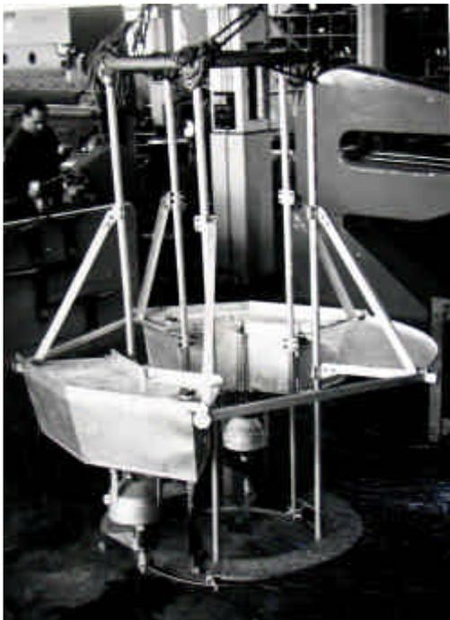
*La structure portant le télescope est réalisée en tubes de duralumin aéronautique AU4G. Le professeur A. Piccard a apporté ses conseils pour sa réalisation. Les bacs à huile (lest) sont en magnésium et l'huile est chaude, servant de système de chauffage. (Collection OPM).*
