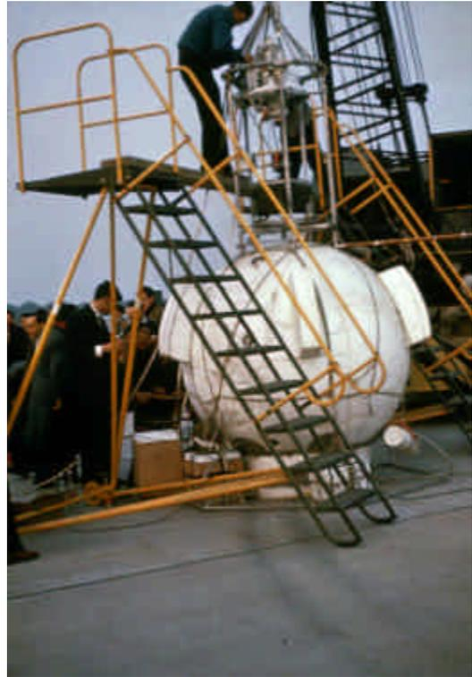
*Le montage de l'ensemble propulseur et capsule portant le télescope est réalisé sur le site de l'observatoire de Meudon à la fin de l'automne 1958. Une grue est nécessaire pour élever les ballons. (OPM).*
