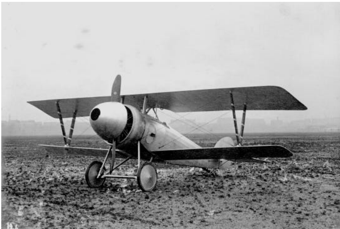
Nieuport 17 bis à moteur caréné : cette fois il existe une possibilité de refroidissement du Clerget 130 ch.
