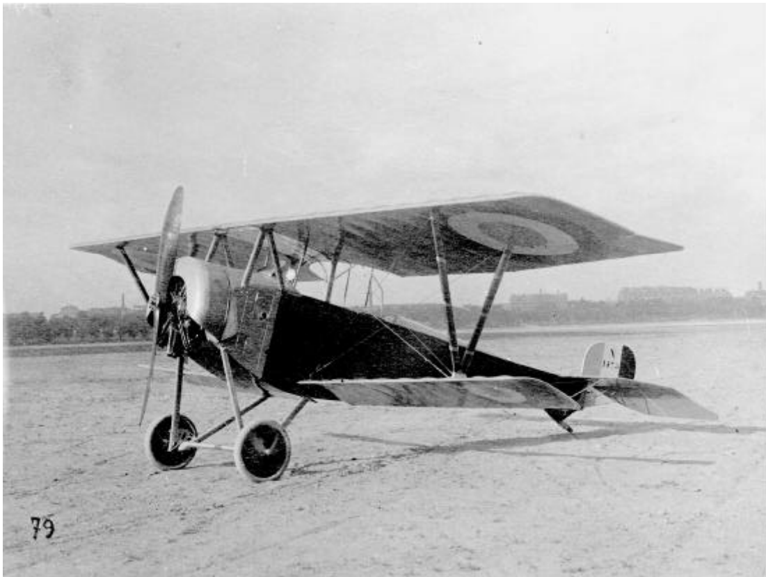
Nieuport biplace d'observation à moteur Clerget 110 ch tardif, du type Nie-12 ou Nie-20, n/c 1475. (SHAA).
