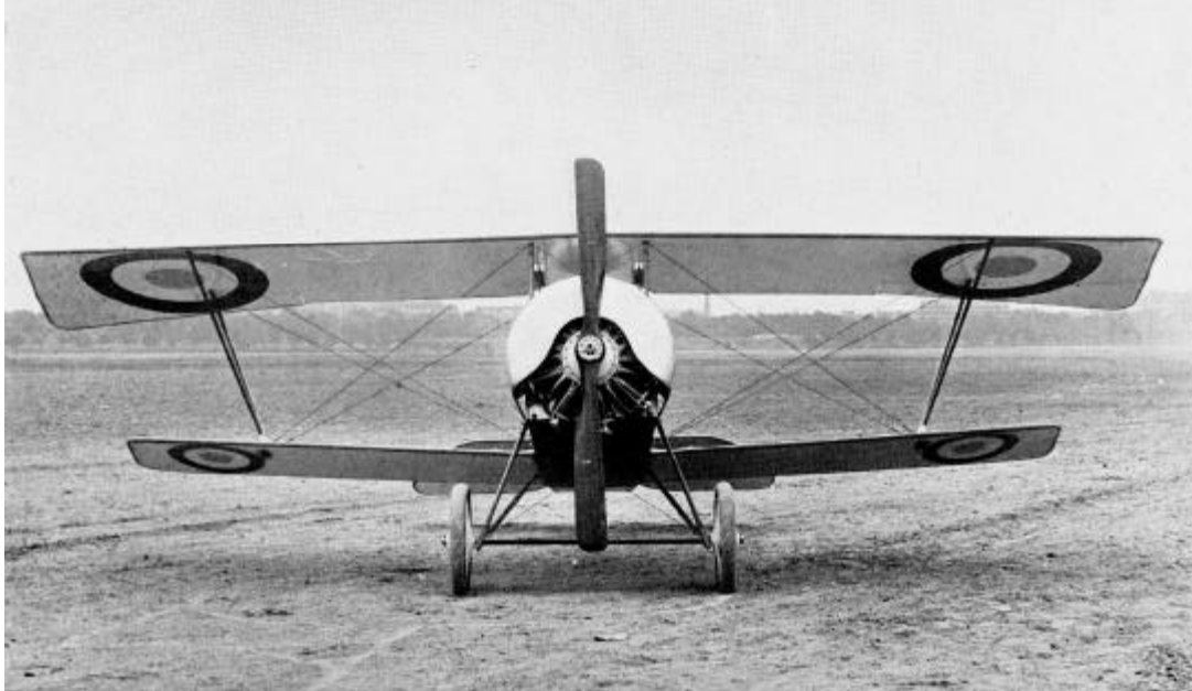
Nieuport 11 à moteur Le Rhône 80 ch. (Catalogue constructeur).
