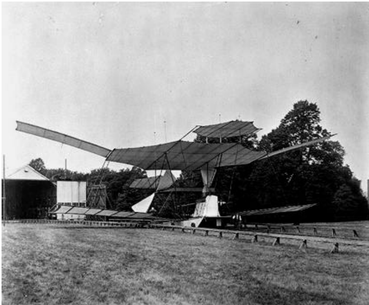
La machine de sir Hiram Maxim (1840-1916) avant un essai, le 31 juillet 1897, dans sa propriété de Baldwyn's Park (Kent). L'énorme engin de 3,5 tonnes est monté sur une voie ferrée de 550 m de long. L'Europe entière s'est passionnée pour cet engin. (Science Museum).
