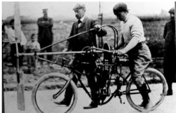
Champion du monde de vitesse à motocyclette, Alessandro Anzani teste la force de traction d'une hélice sur sa motocyclette à moteur Buchet, à la demande de Ernest Archdeacon, le 18 septembre 1906. Anzani démontre qu'une hélice adéquate mue par un moteur de seulement 6 ch entraîne un poids de 150 kg à 80 km/h, soit avec un rendement de plus de 90 %.
