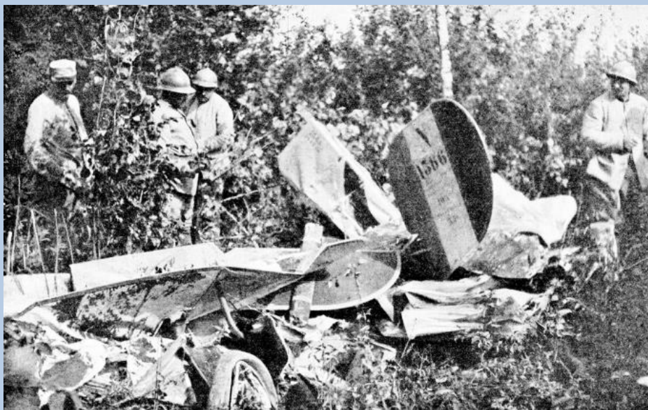
Ce qu'il reste du Nieuport de l'aviateur français de Terline après la collision et le crash. (LPG).
