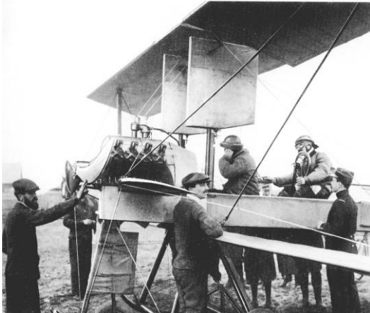
Le Breguet type II en décembre 1908. Premier client de Renault, Breguet utilise le Renault 50 sur ses machines volantes. (Musée Renault).
