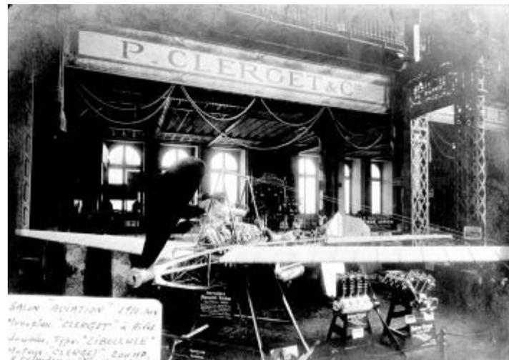
*Le monoplan Archdeacon-Clerget avec ses ailes doubles. Le moteur est installé au centre de gravité entre les ailes.*
