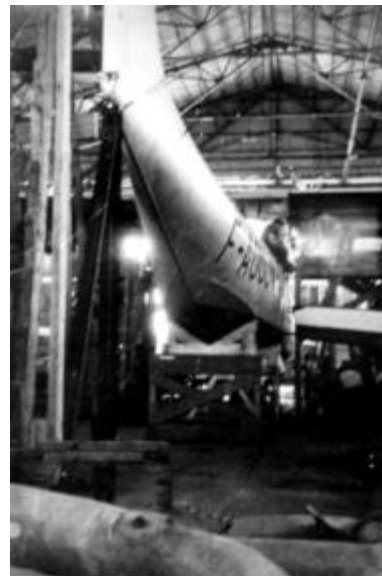
Le H-24-6 en construction à Argenteuil. (Coll. Violleau).
