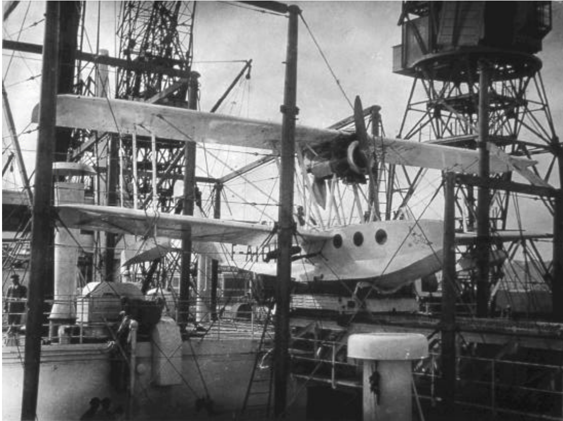
LeO H-19 embarqué, type H-198-2 (Marine nationale). Dérivé du LeO H-13, ce biplan à coque bi-moteur fut abondamment utilisé pour transporter du courrier depuis un bateau rapide.
