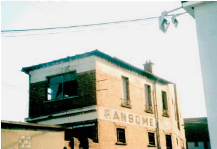
La bâtiment Ransome d'Argenteuil, rue Claude Monet avant sa démolition en 1999.
