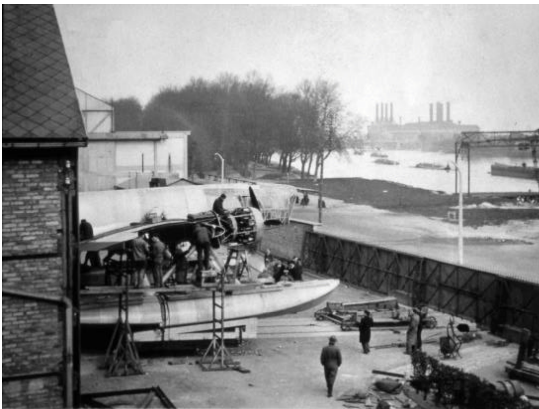
Le Lioré et Olivier 46 en construction à Argenteuil début 1936. On distingue au fond les usines de traitement des esaux de Gennevilliers et à droite les usines Gnôme & Rhône. (Cliché Musée de l'Air).
