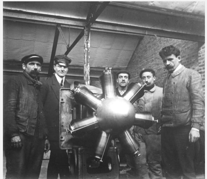
Essai de casserole d'hélice carénée sur moteur Oméga à Gennevilliers (1912). Ce dispositif permet à un moteur Gnome de remporter la Coupe Gordon-Bennett en 1913. (Collection Xavier Passot).
